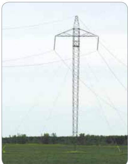
emplacements des pylônes électriques seront marqués. Les fondations des pylônes seront construites, les pylônes seront assemblés, montés et installés et les câbles électriques seront ensuite posés entre les pylônes. La ligne de transmission sur terre sera testée avant d'être utilisée.
